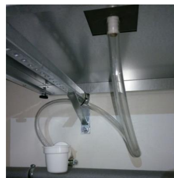
Napojení odvodu kondenzátu
